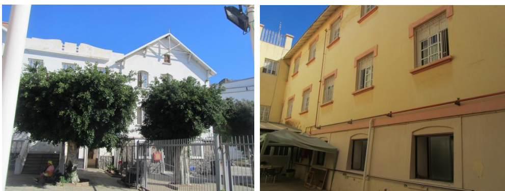
Imágenes actuales de la fachada del edificio remontado y del patio cerrado.
