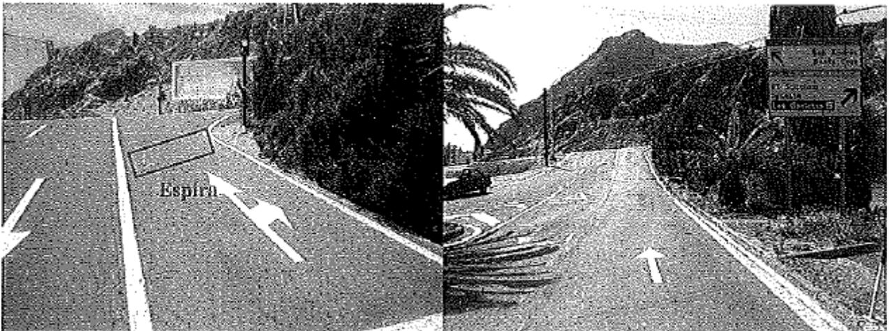
**Imagen nº 25:** Localización de la espiral para aforar en la salida del aparcamiento de la playa de Las Teresitas
