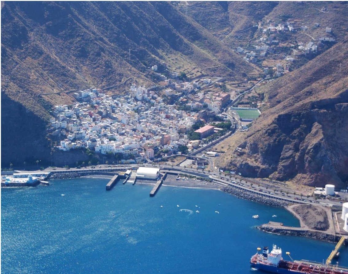
Panorámica oblicua del área correspondiente a la 'Playa de Arena del Litoral de Valleseco'.
