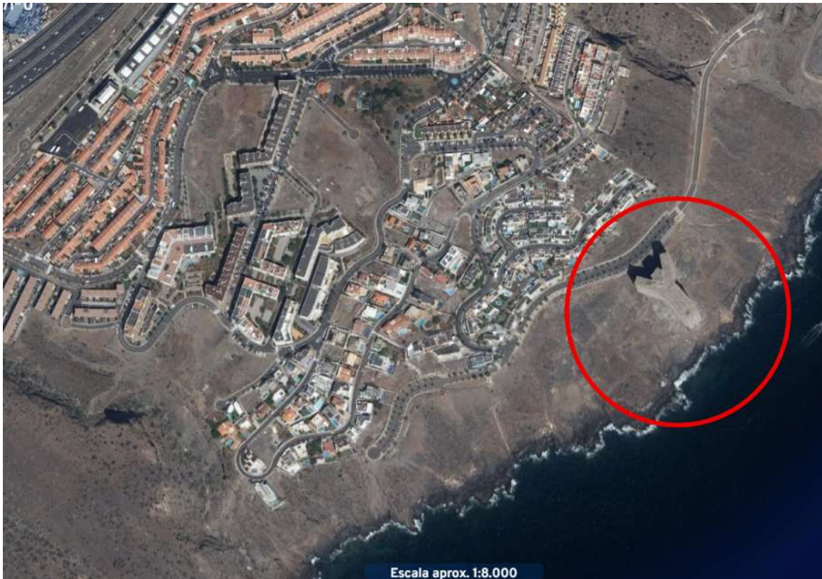
Situación de la finca 10911 sobre Ortofoto de fecha 16-03-2024. Fuente: Gerencia Municipal de Urbanismo.
