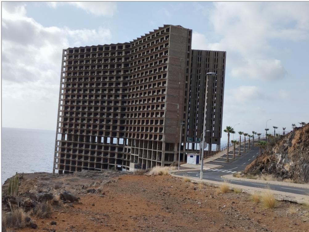
Vista general de la parcela (edificación denominada "mamotreto")
