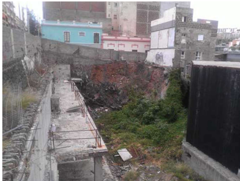
Ilustración 16 Imágenes del entorno de la UA en el interior de las parcelas de la actuación.
